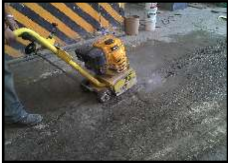
Limpieza mecánica o química
